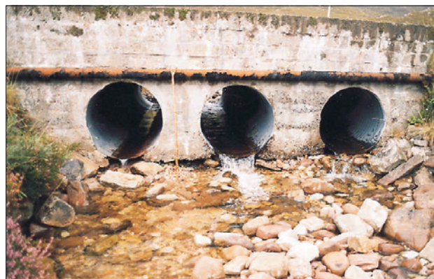
Culvert pipes on Am Fionn Alltan ( K Starr )
